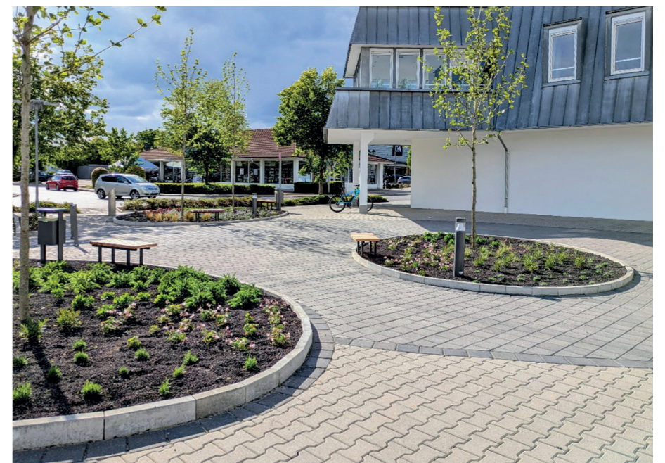
Der neue Quartiersplatz im Stadtberger Markt: wo sich bislang die Zufahrt zum Parkdeck befand, stehen nun Sitzbänke und ein Trinkwasserbrunnen. Text und Fotos: Martin Bruckmeier, Stadt Stadtbergen.
