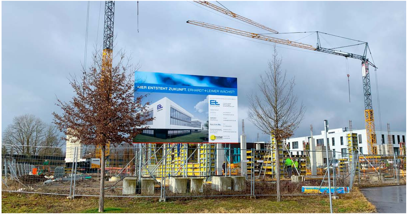
Im Sheridan Park in Augsburg-Pfersee entsteht derzeit das neue Betriebsgebäude der Erhardt+Leimer Elektroanlagen © E+L
