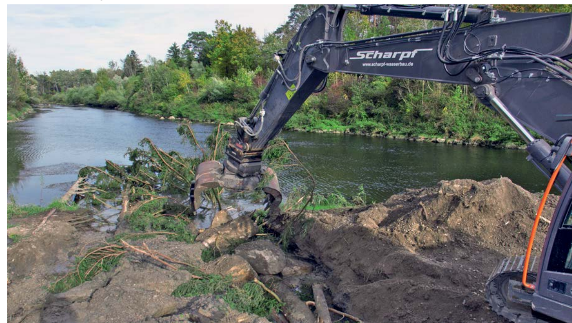
Vor einigen Jahren wurde am Ufer unterhalb der Staustufe Inningen schon mal Totholz eingebracht. Auf und neben die alten Stämme hat LEW Wasserkraft nun mit Hilfe eines Baggers insgesamt fünf neue Fichten eingebracht und fixiert. Das feine Astwerk ist für viele Tierarten ein wertvoller Lebensraum.
