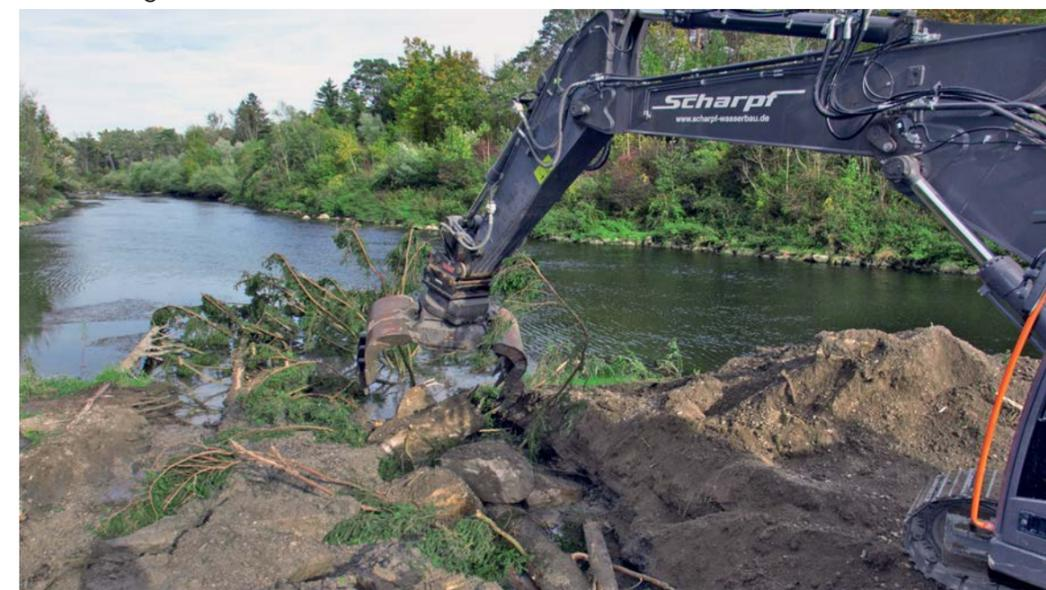
Vor einigen Jahren wurde am Ufer schon mal Totholz eingebracht. Auf und neben die alten Stämme hat LEW Wasserkraft nun mit Hilfe eines Baggers insgesamt fünf neue Fichten eingebracht und fixiert. Das feine Astwerk ist für viele Tierarten ein wertvoller Lebensraum.
