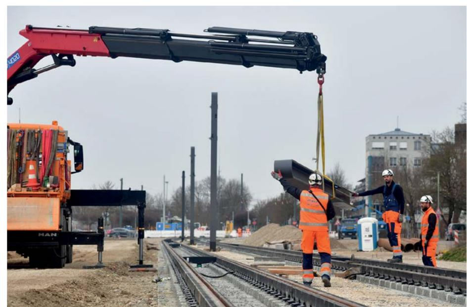
Insgesamt werden 110 Fahrleitungsmasten ab der Inninger Straße Richtung Süden aufgestellt. Hier werden im Anschluss die Fahrdrähte montiert, durch die der Strom für die Straßenbahnen fließt.
