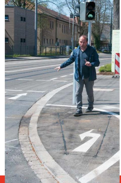
forderung durch Schleifen geschaltet. Zusätzlich gibt es für Radfahrer und Fußgänger Schleifen und Anforderungsschalter (Bild links: der Schalter muss nicht gedrückt werden, wenn die Schleife überfahren wird!)
