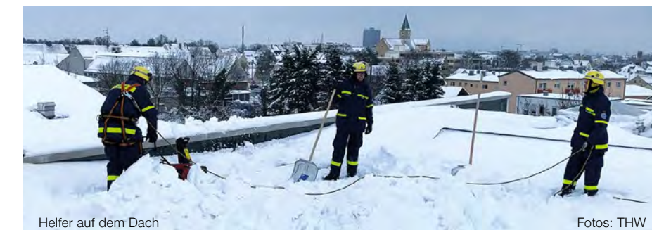
Helfer auf dem Dach
