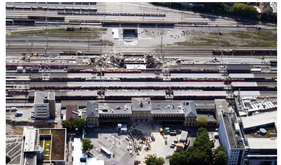
Die Baustelle unter dem Augsburger Hauptbahnhof aus der Nähe besichtigen ist im September und Oktober wieder möglich. Foto: swa / Thomas Hosemann
