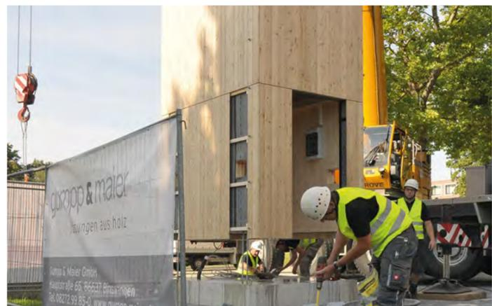
Mit schnell härtendem Beton werden die Halterungen befestigt
