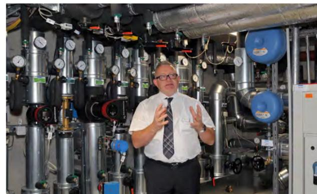
Das technische Herzstück des Gebäudeklimas, die Heizungs- und Kühlungsanlage sorgt – zusammen mit der Be- und Entlüftung – für eine ganzjährig gleichbleibende Temperatur von 22 bis 23 Grad Celsius in sämtlichen Räumen der 5790 Quadratmeter Mietfläche, ausgenommen der Gastronomie, wegen deren besonderen Gegebenheiten.
