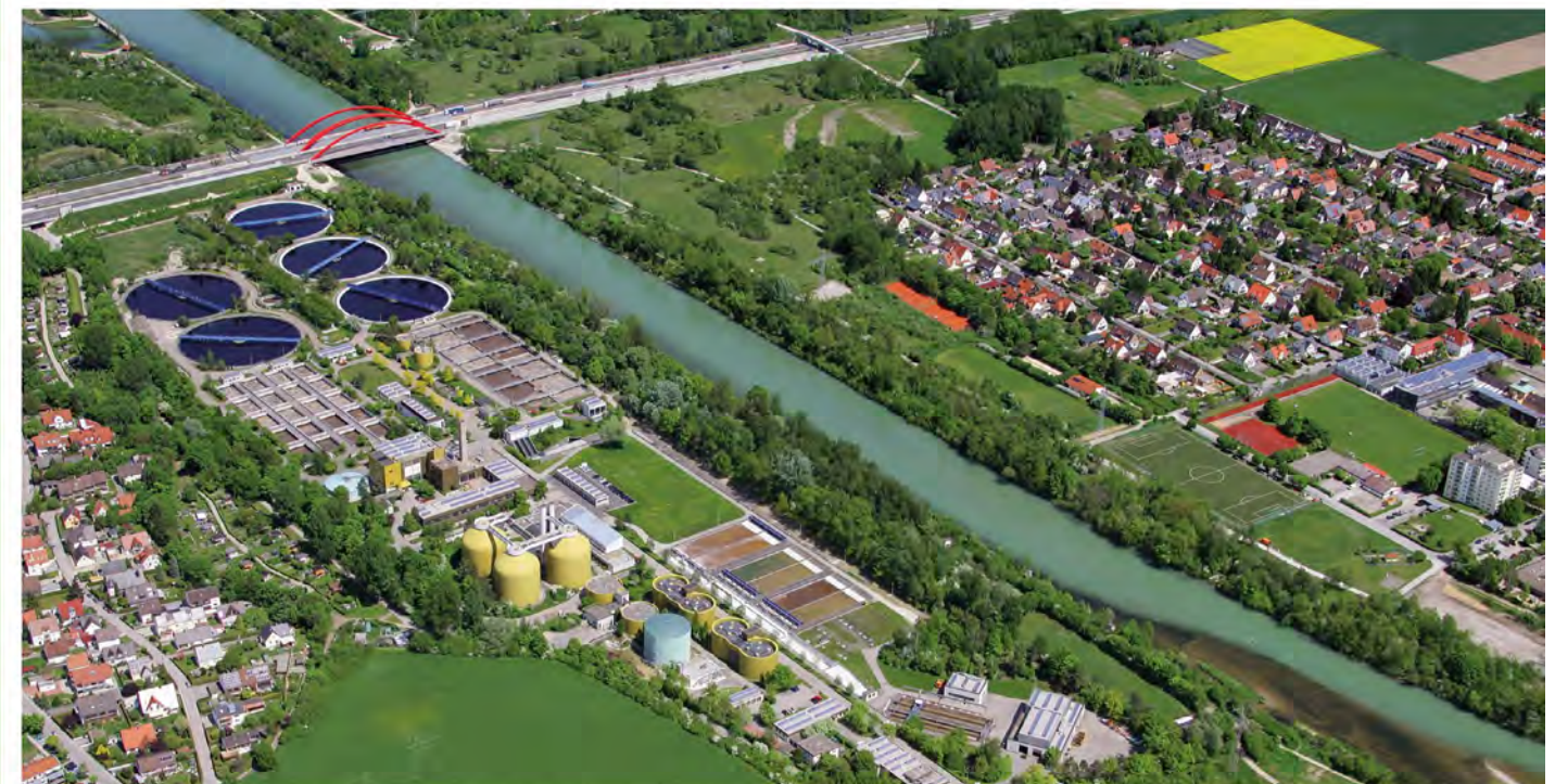
Untertitel: Verbandskläranlage Augsburg/Stadtbergen
